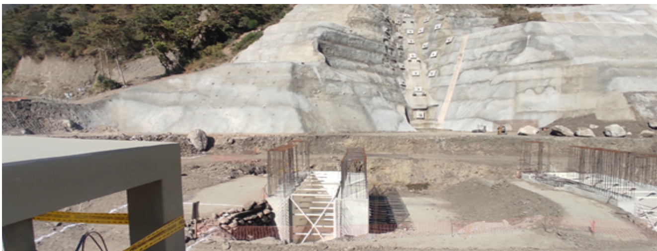
Avance de obras Casa de Máquinas Umapalca.
