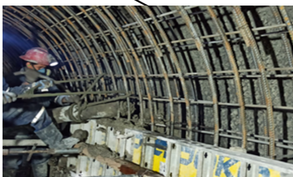
“Túnel Secundario – Central Hidroeléctrica San José”
